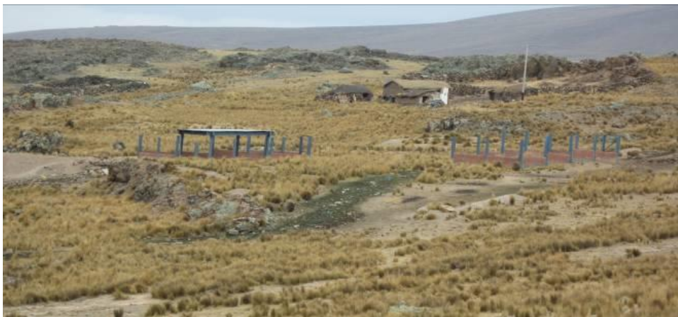
Fotografía N° 11: Red pública de desagüe.
