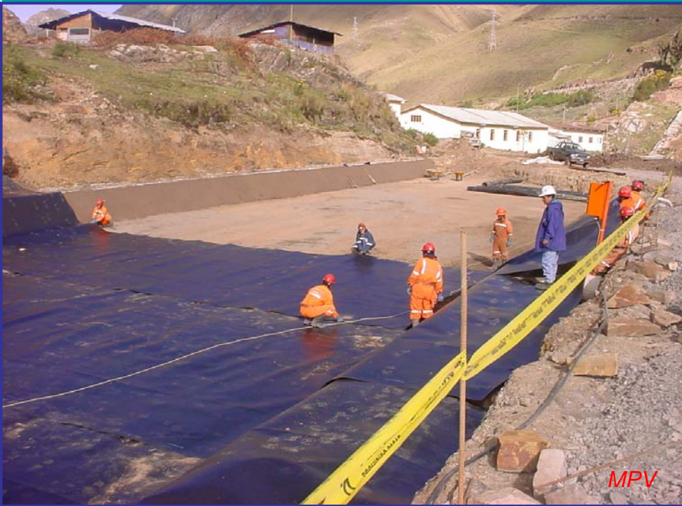
Impermeabilización con geomembrana
